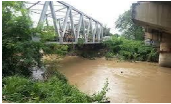
Gambar 4.1 Kondisi Sungai Cibanten
